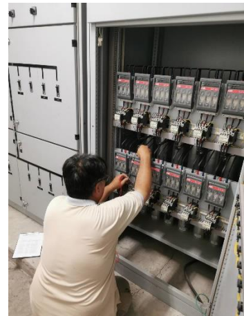
ตรวจวัดโดยกล้องตรวจจับความร้อนที่ main breaker ของคาปาซิเตอร์
