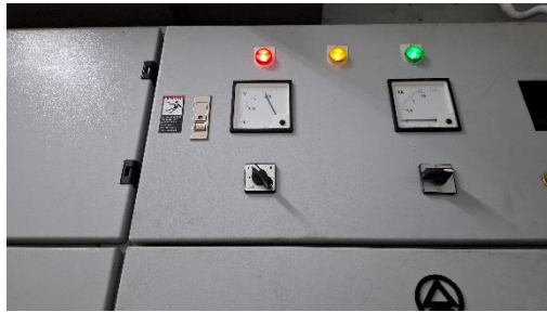
ตรวจอุปกรณ์เครื่องวัด Volt meter + Selector, Amp meter + Selector
