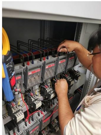
ตรวจวัด FUSE ของคาปาซิเตอร์
