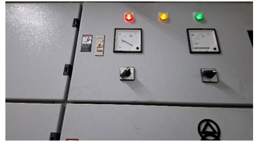
ตรวจอุปกรณ์เครื่องวัด Volt meter + Selector, Amp meter + Selector
