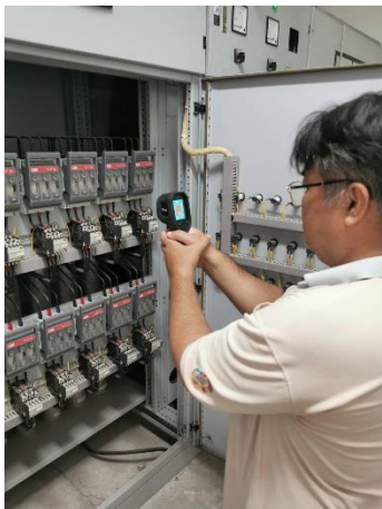
ตรวจวัดโดยกล้องตรวจจับความร้อนที่ main breaker ของคาปาซิเตอร์
